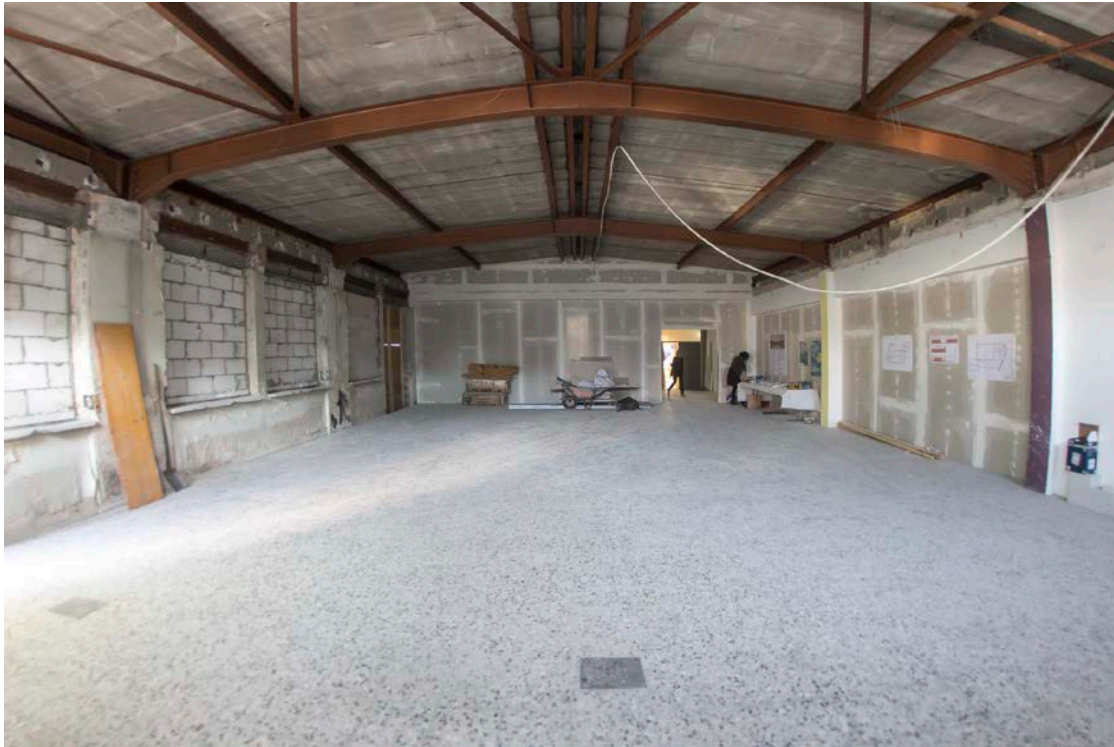
Umbau einer ungenutzten Lagerhalle
