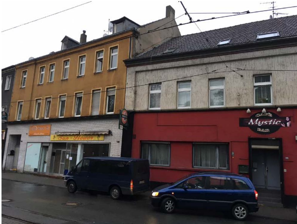
Leerstände, Instandhaltungsrückstände Sozialverträglicher Mieterumzug, Modernisierung
