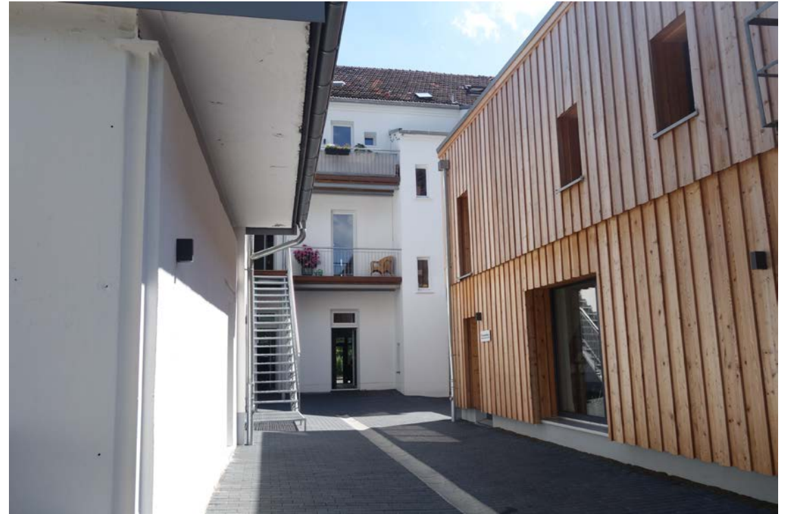
Hinterhofpotentiale entwickeln – Tonstudio in ehem. Metzgerhalle
